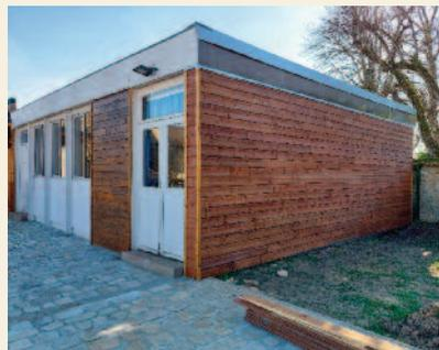
L'isolation du mur de la Salle L'Ecole, côté nord, a été améliorée avec la pose de laine de verre de 200 millimètres et d'un bardage en bois.
