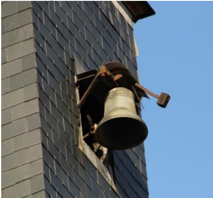
La cloche civile reliée au cadran de l'horloge
